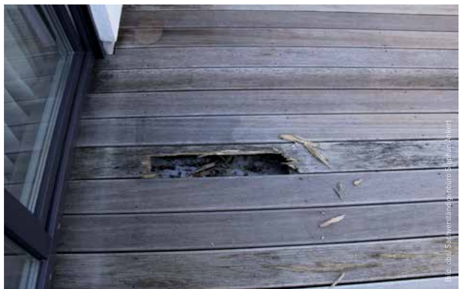
Ein Fall für den Sachverständigen: Terrassendielen mit zu geringer Lebensdauer.
